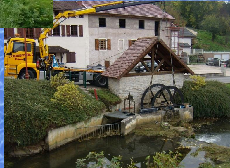
**La roue du moulin a fait l'objet de plusieurs interventions : le remplacement d'un roulement en juin 2010 puis de la roue elle-même en acier plutôt qu'en bois.**
