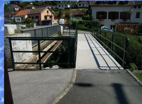
**La passerelle piétonne sur le Rupt a été refaite à l'été 2015 en béton plutôt qu'en bois dans un soucis de longévité.**
